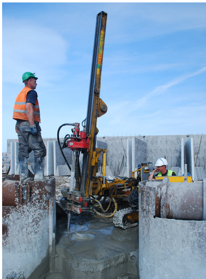
DOSZCZELNIANIE GRODZIC STALOWYCH
