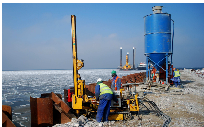
STANOWISKO ROBOCZE – FORMOWANIE KOLUMNY INIEKCYJNEJ
