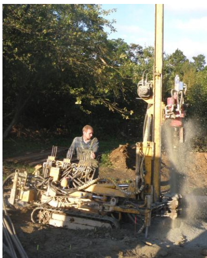
PRZEWIERT MŁOTKIEM WGLĘBNYM
