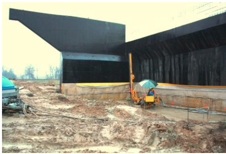
REALIZACJA KOLUMN „JET GROUTING” POD PODPORĄ ZEWNĘTRZNĄ „H”
