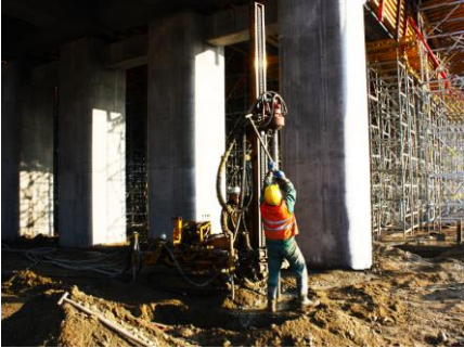
REALIZACJA KOLUMN „JET GROUTING” POD PODPORĄ POŚREDNIĄ „D”
