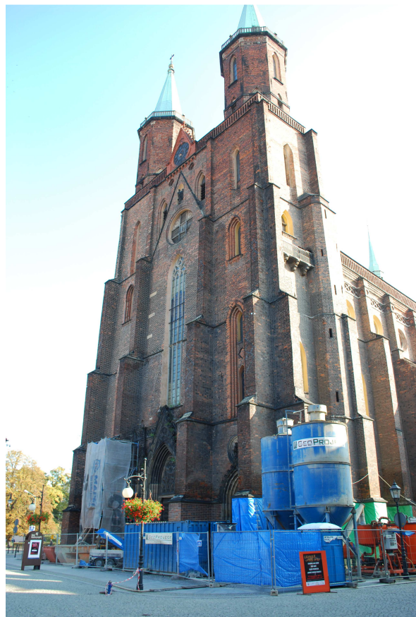
ZAPLECZE BUDOWLANE PRZY KOŚCIELE
