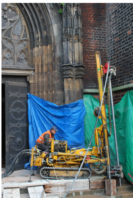
WIERCENIE KOLUMN „JET GROUTING”
