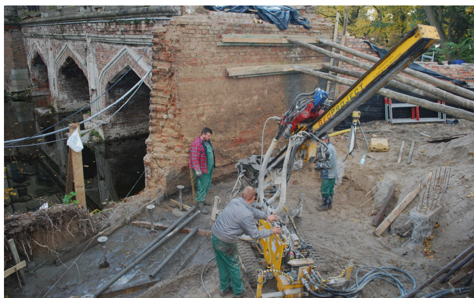
WYKONAWANIE MIKROPALI POD PRZYZCÓŁKIEM MOSTU
