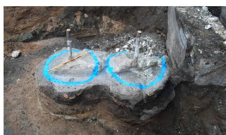
PALE INIEKCYJNE W SĄSIEDZTWIE ISTNIEJĄCEGO FUNDAMENTU
