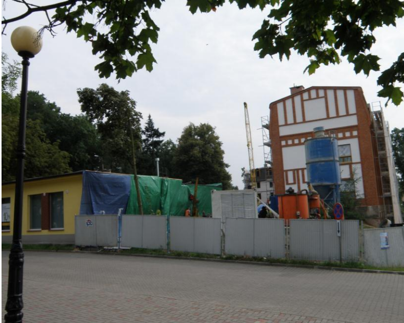
WĘZEŁ TECHNOLOGICZNY NA MIEJSCU BUDOWY
