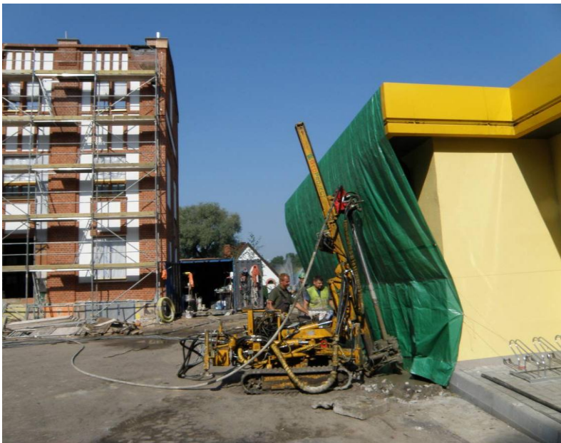
FORMOWANIE KOLUMN „JET GROUTING” OD STRONY PROJEKTOWANEGO GARAZU
